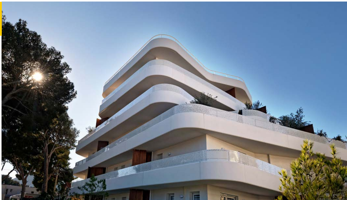
Opéra Nature, Marseille. 45 logements locatifs abordables.
